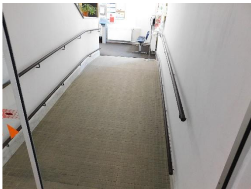
Vjezdová rampa do budovy
